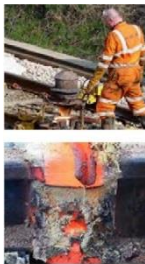
از آهن مذاب تولید شده در واکنش ترمیت برای جوش دادن خطوط راه آهن استفاده می شود.
